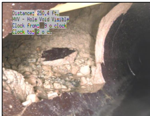
Hole Void Visible MH0101:MH0092
